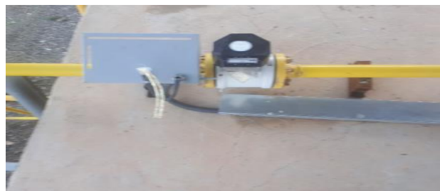
شکل ۲- شماتیک کنتور اندازه گیری سوخت تغذیه گرمکن
