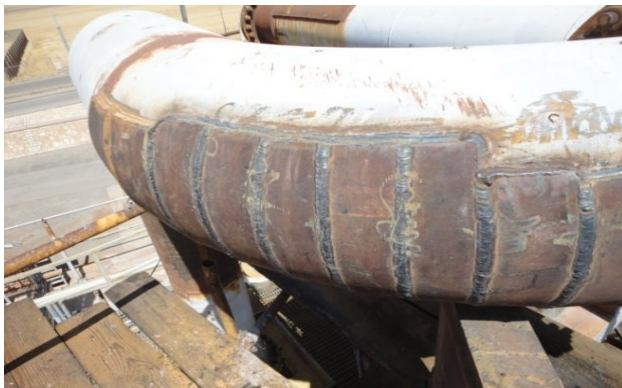
شکل ۶- جوشکاری خط لوله کربن استیل خورده شده در اثر اسید فلوریدریک [۱۷]
