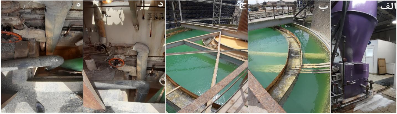
شکل ۲- تصویر الف: تهیه آب آهک، ب و ج: زلال کننده؛ خروجی پساب و لجن زلال کننده در نیروگاه بخار شهید منتظر قائم.
