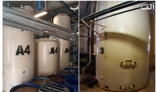
شکل ۳- تصویر تصفیه‌خانه نیروگاه بخار شهید منتظر قائم. الف: فیلتر شنی و ب: فیلترهای کاتیونی، آنیونی و بستر اختلاط یافته.
