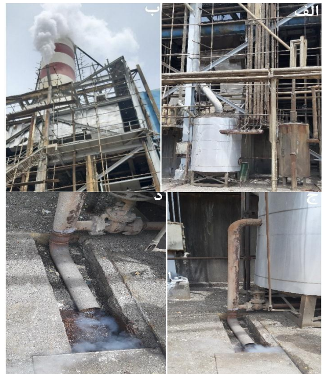
شکل ۴- تصویر الف: تانک زیرآب (بلودان)، ب: بخارات خروجی از تانک زیرآب و ج: کانال انتقال زیرآب و کلین تخلیه در نیروگاه بخار شهید منتظر قائم.
