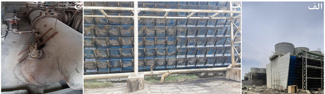
شکل ۶- تصویر الف و ب: برج‌های خنک‌کننده تر و ج: خط خروجی زیرآب.
